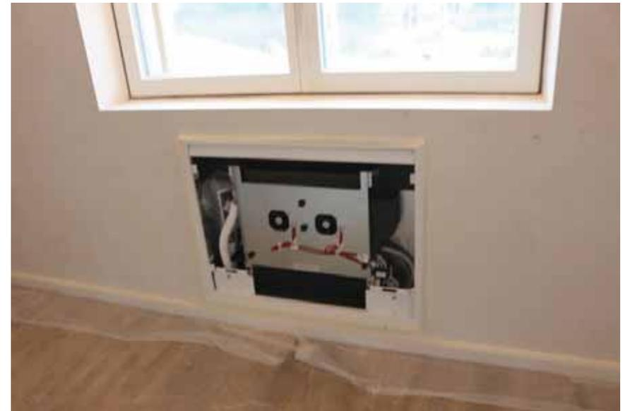
Terminali riscaldamento e raffreddamento. Ventilconvettori con pannello frontale radiante.
